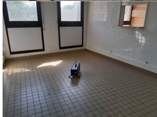
Laboratoire : Sol carrelé Séparatifs verticaux et horizontaux entre locaux, en béton
