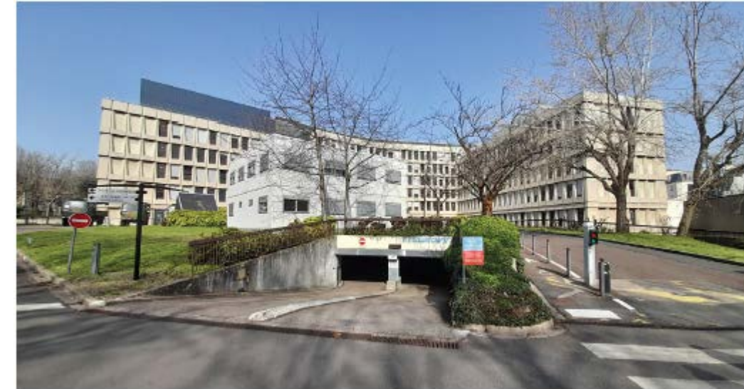
Vue sur la façade sud du monobloc, au premier plan l'accès aux parkings (APUR)
