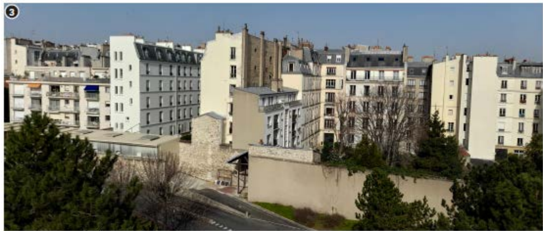
Vue sur les parcelles adressées rue Claude Bernard.
