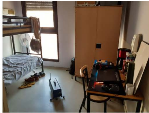
Chambre : Sol PVC Séparatifs verticaux et horizontaux entre locaux, en béton
