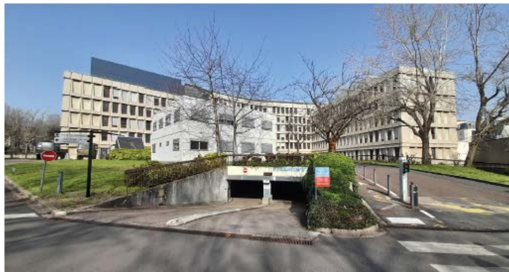
Vue sur la façade sud du monobloc, au premier plan l'accès aux parkings (APUR)
