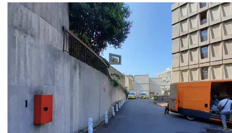
Espace de circulation routière façade est de l'hôpital (EPAURIF)
